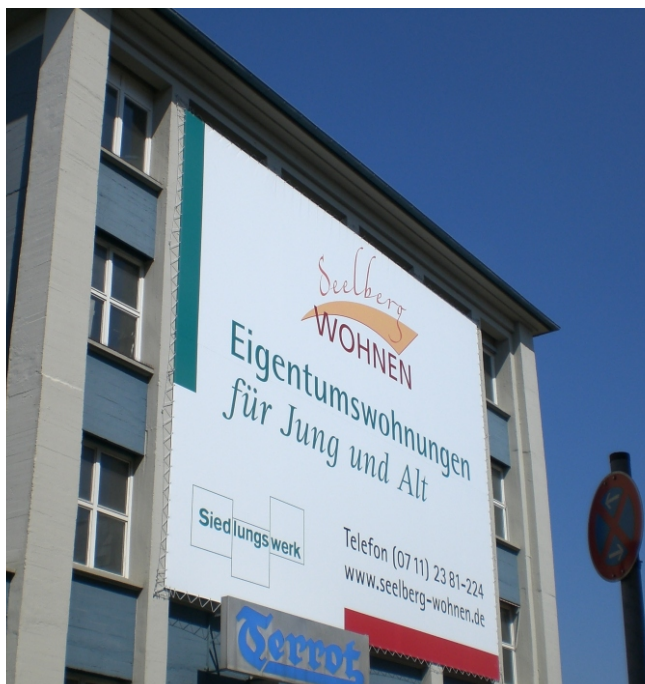
Großplane 10 x 7 m, mit Stahlseilen an Wand verankert und Plane mit Gummiseilen verspannt
