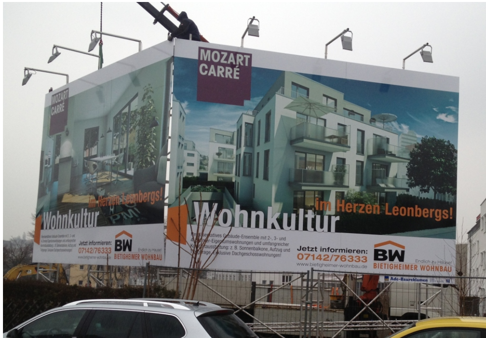
Alu-Dreieckskonstruktion mit jeweils 700 x 500 cm großen Schildern und Beleuchtungsanlage mit je drei HQI-Strahlern
